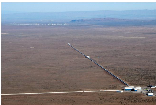
LIGO Hanford. O Laboratório LIGO opera dois locais de detectores, um próximo a Hanford, no leste de Washington, e outro próximo a Livingston, na Louisiana. Esta foto mostra o local do detector de Hanford. Disponível em https://www.ligo.caltech.edu/image/ .
