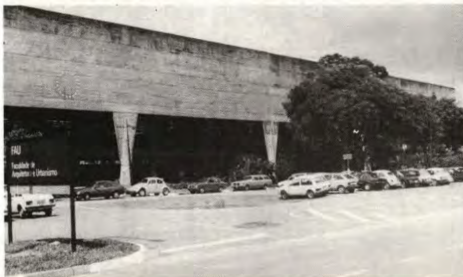
O prédio da FAU, projetado por João Batista Villanova Artigas entre 1967/68, é uma amostra da moderna concepção arquitetônica
