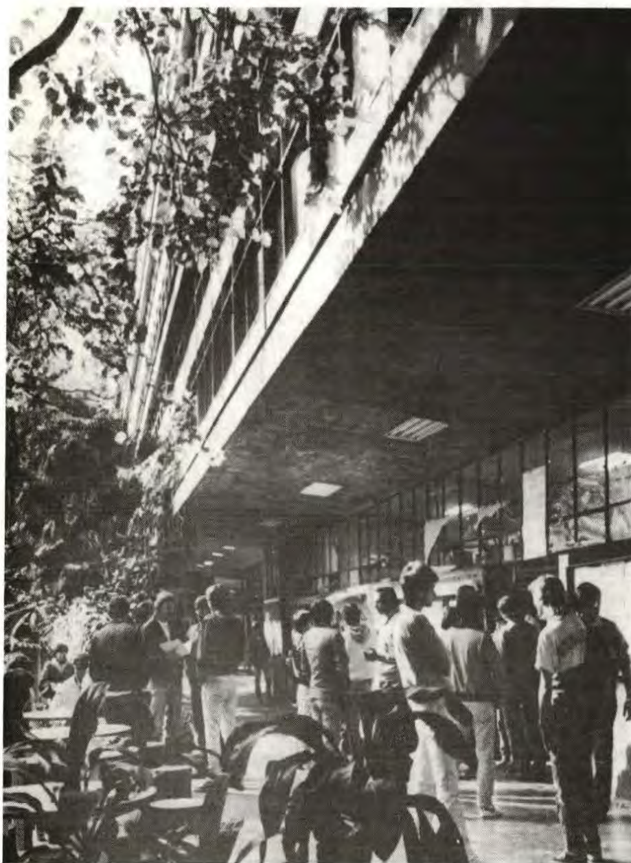
Vista parcial do edifício sede da Escola de Engenharia de São Carlos
