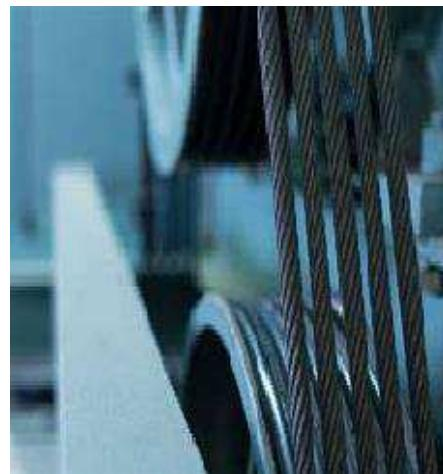
Durante a inspeção, foi verificado em um dos elevadores que o cabo central apresenta desgaste e rompimento de mais de seis fios. Para atender à norma de segurança a empresa de manutenção deve realizar a troca
